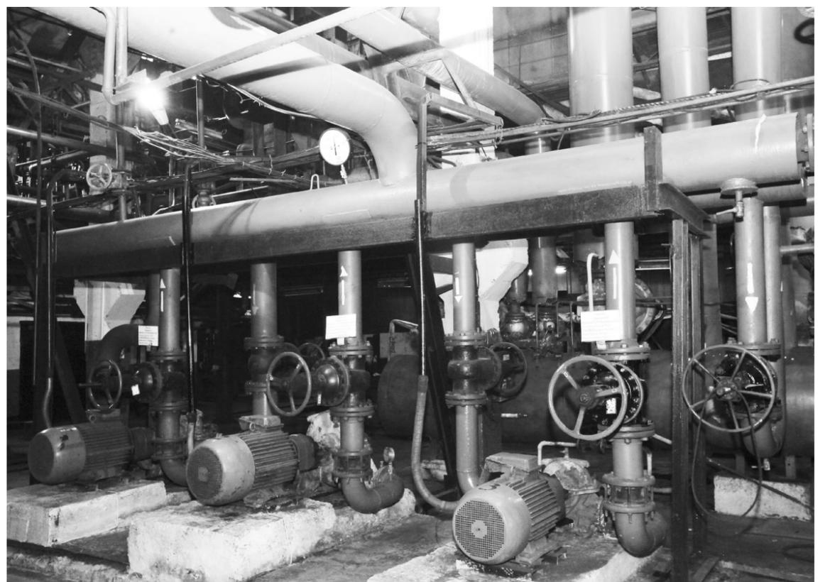
■ Для всего насосного оборудования в Тайге установлены частотные преобразователи, что дает очень хорошую экономию электроэнергии
