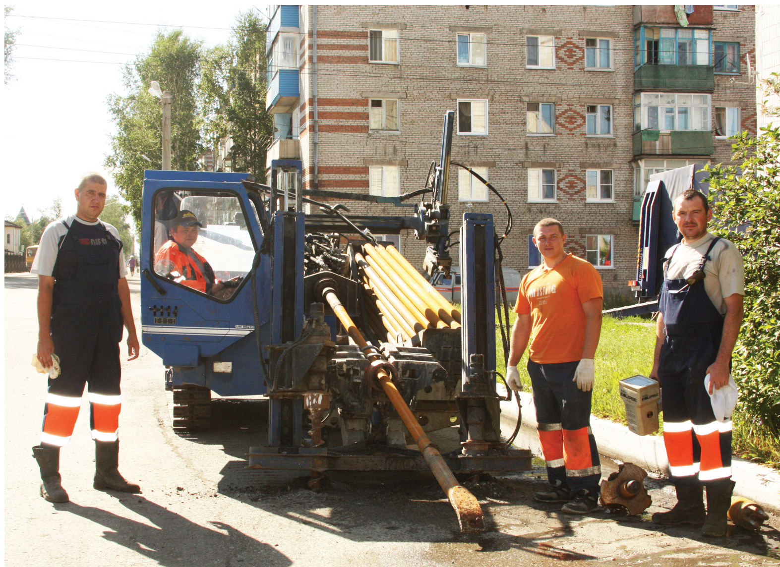
■ Сотрудники ООО «Кемвода» ведут подготовительные работы
