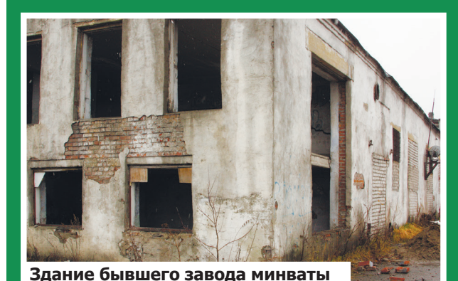
Здание бывшего завода минваты
