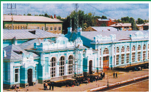
Здание ж/д вокзала
