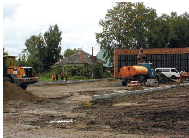
Мемориал, идут ремонтные работы
