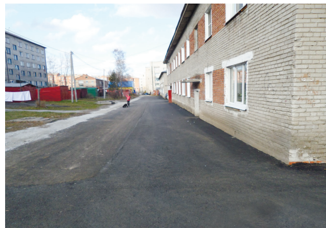
ул. Строительная, 37, ПОСЛЕ
