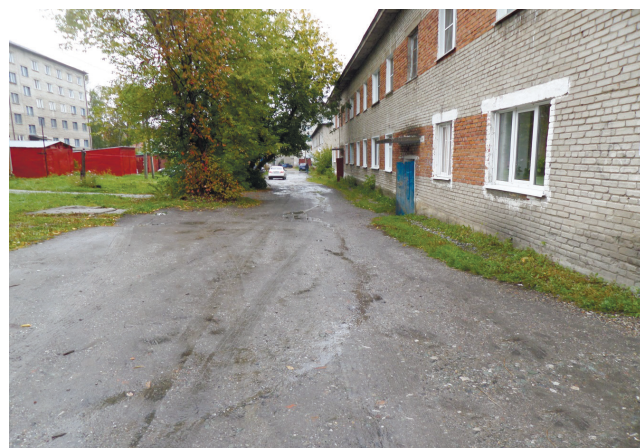
ул. Строительная, 37, ДО
