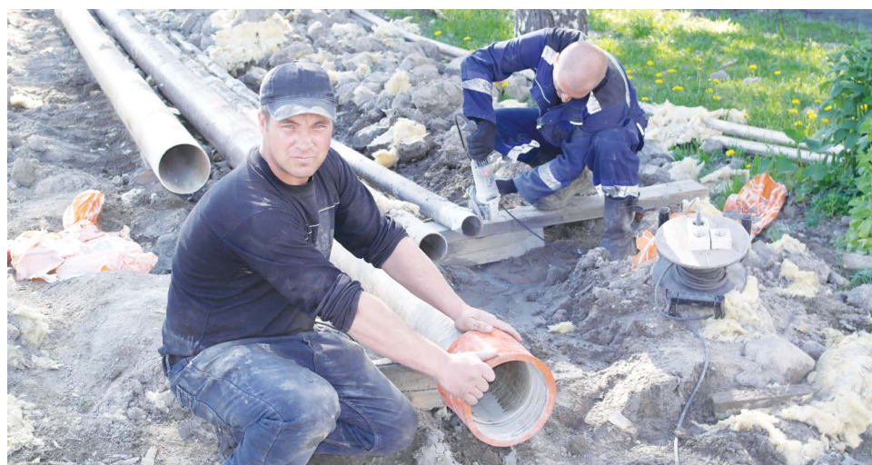
■ Ведётся укладка труб
