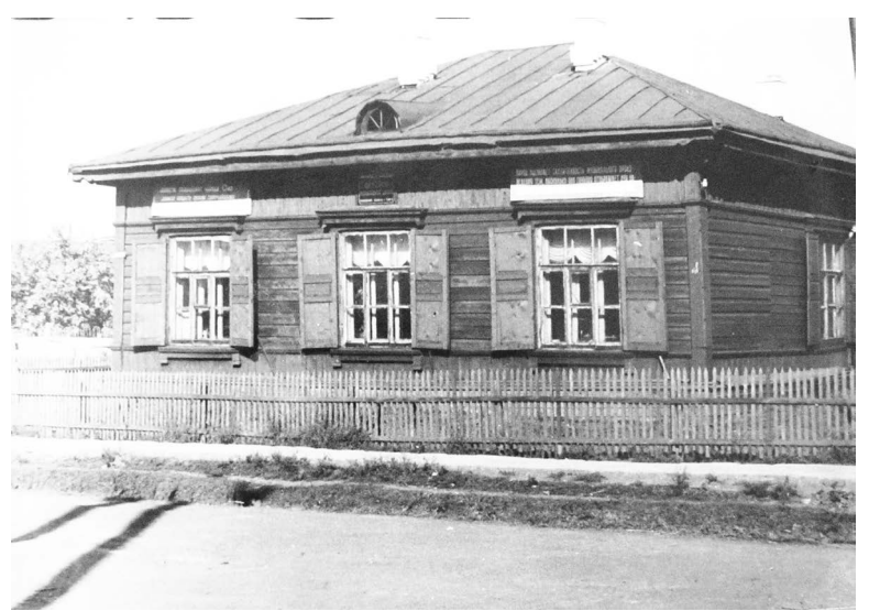
■ Здание школы 1956 г. по улице Перееззная
