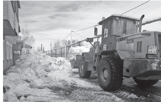
■ АО «Дорожник» вывозит снег
