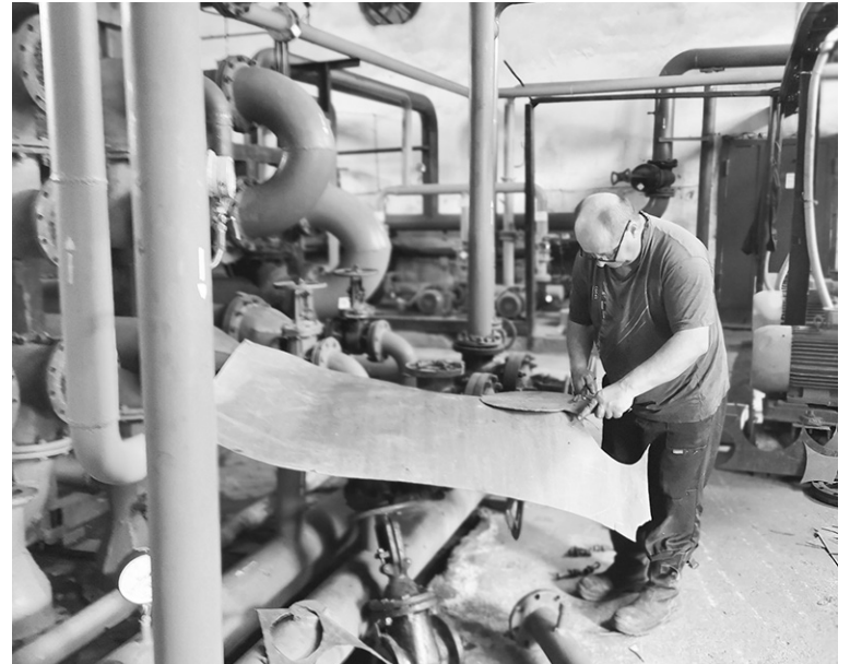
■ Ремонт теплообменников на ЦТП №3.
