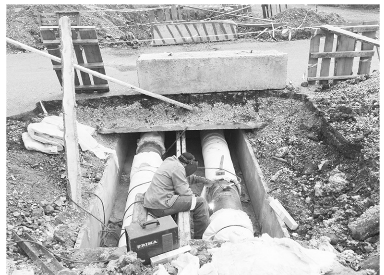
■ Ремонт теплотрассы.
